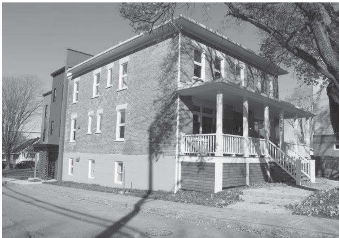
La maison mère fraîchement rénovée! Nouvelle adresse civique : 55 Ave. du Pont Scott (anciennement 990 St-Vallier Ouest) Photo Mariève St-Jean
